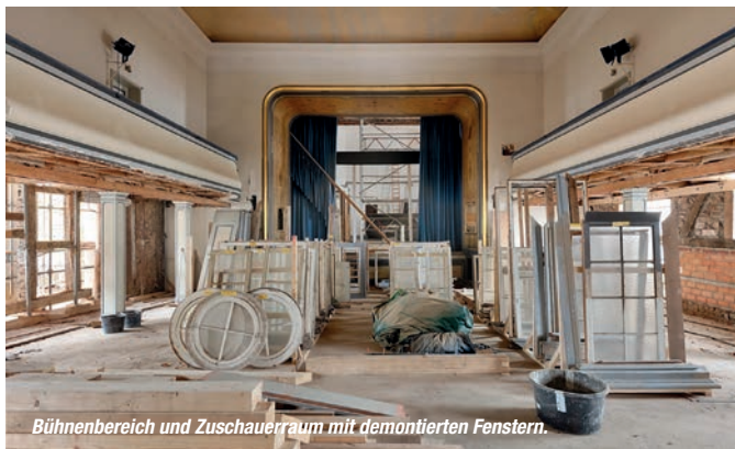
Abstützmaßnahmen Fachwerksanierung Westfassade am Kurtheater. Foto: Staatliches Baumanagement Weser-Leine
