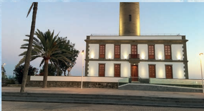
Leuchtturm Maspalomas, Gran Canaria. Foto: P. Fischer
